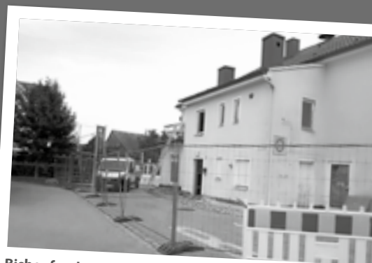
Bisher fanden vor allem Entrümpelungs- und Entkernungsarbeiten statt.
